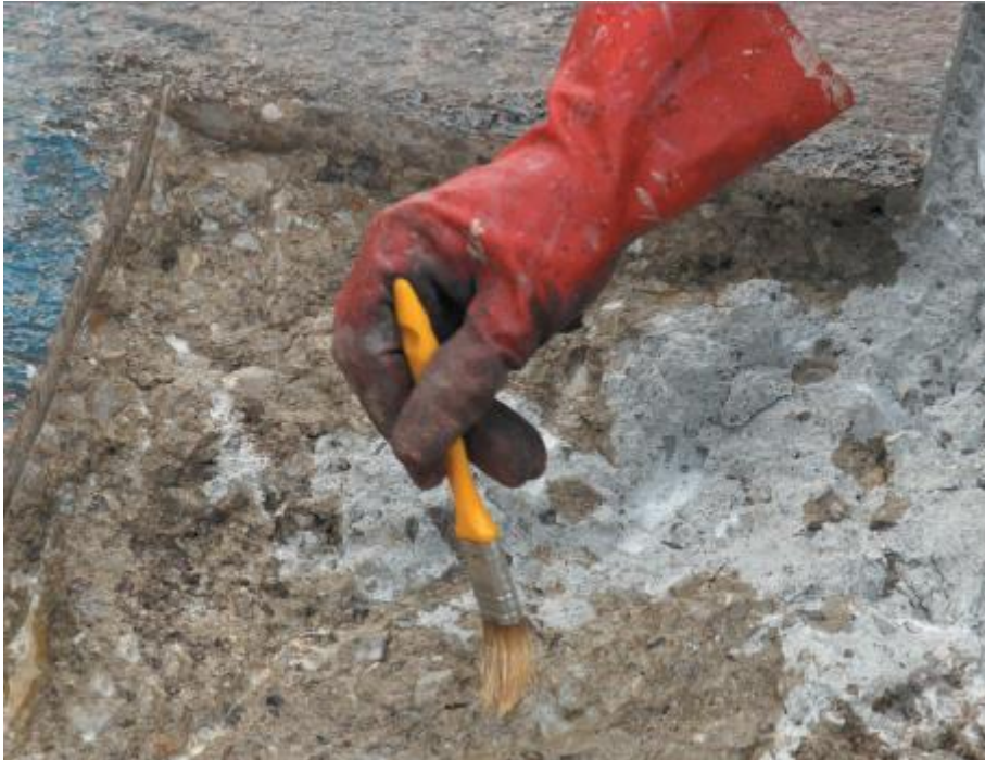
Picture 7 – Primer application
